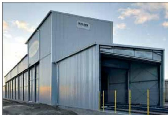
2018 bei Delco installierter Mühlböck-Kanaltrockner „Dynamic 1003 Premium“ mit einer jährlichen Trocknungskapazität von 100 Mio. Bft (rund 235 000 m<sup>3</sup>)
