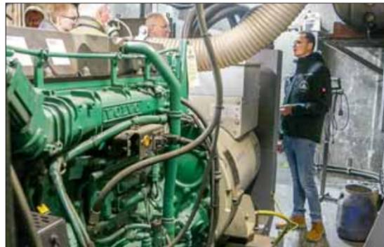
Im Werk in Unterrodach wird mangels eines ausreichenden Netzanschlusses eigener Strom mit einem 500-PS-Volvo-Motor (hier im Bild) und einem 450-kV-Generator erzeugt, mit dem alle Maschinen und Anlagen betrieben werden.
